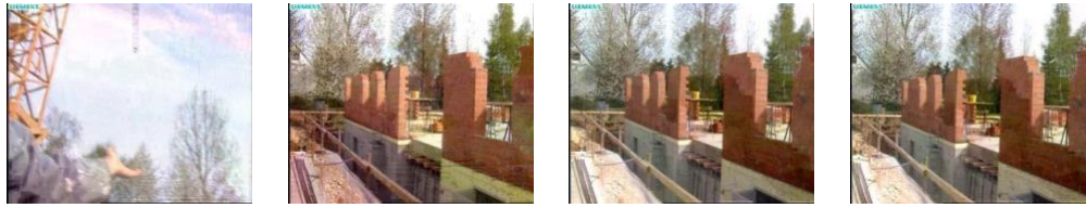
(e) frame201 (f)frame251 (g)frame252 (h) frame301
