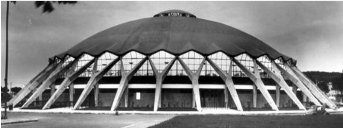
Figure 8 Palazzetto dello Sport
