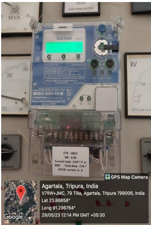
Fig: Trivectometer
