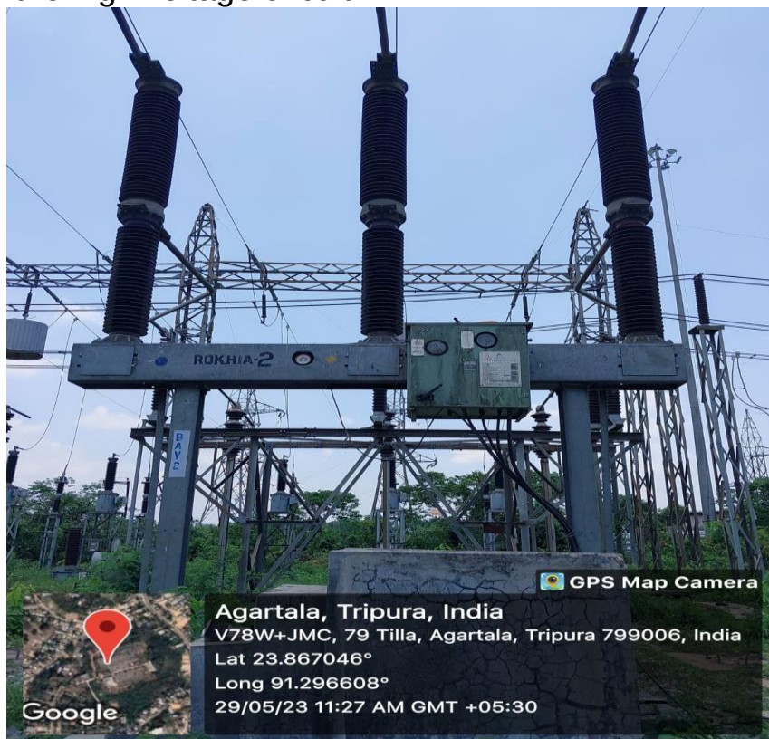
Fig: SF6 Circuit Breaker
