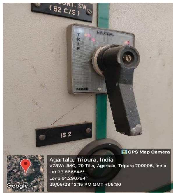
Fig: Tripping switch
