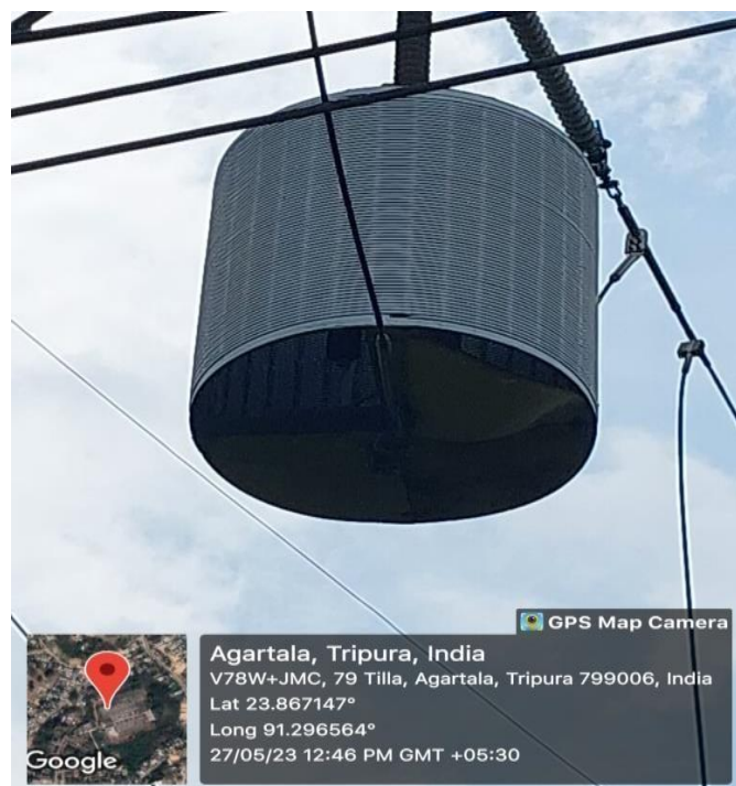
Fig: Wave Trap
