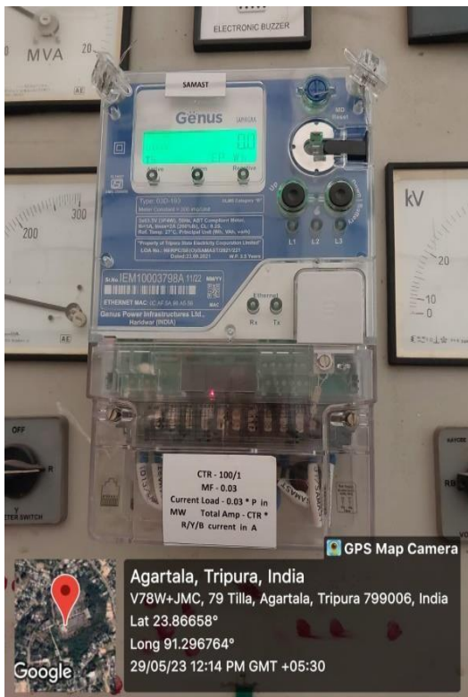
Fig: Trivectometer
