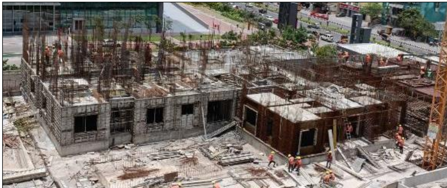
2 ND FLOOR SLAB POUR 2 IN PROGRESS
